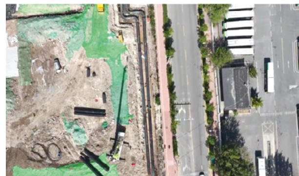
（老旧管网改造工程）
