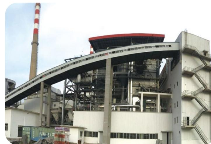
通過對生物質機組運行問題的逐項攻關，恒源熱電生物質機組優化提升改造創新項目取得顯著成效。機組運行穩定性、經濟性、靈活性大幅提高，非計劃停爐的次數顯著減少，達到了運行周期可控的目的，為同行業同類型機組技術改造提供了可參考的經驗；在能耗指標方面，機組發電耗標煤由200gce/kWh降低至165gce/kWh、供熱耗標煤由46kgce/GJ降低至40.5kgce/GJ，鍋爐熱效率由61%提升至84%，年可節約標煤量6400噸，達到了同行業採用高、低差速床生物質循環流化床鍋爐發電企業中的較高水平，並成功入選《全國可再生能源供暖（制冷）典型案例匯編（2024）》。
